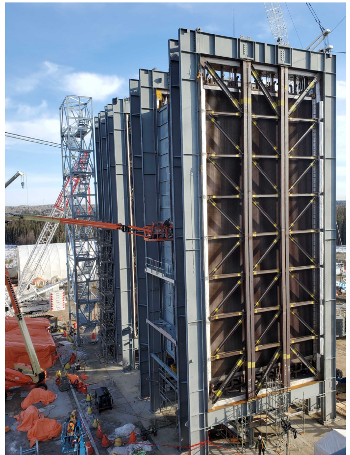
Installation of burner casing panels on HRSG Unit 10
